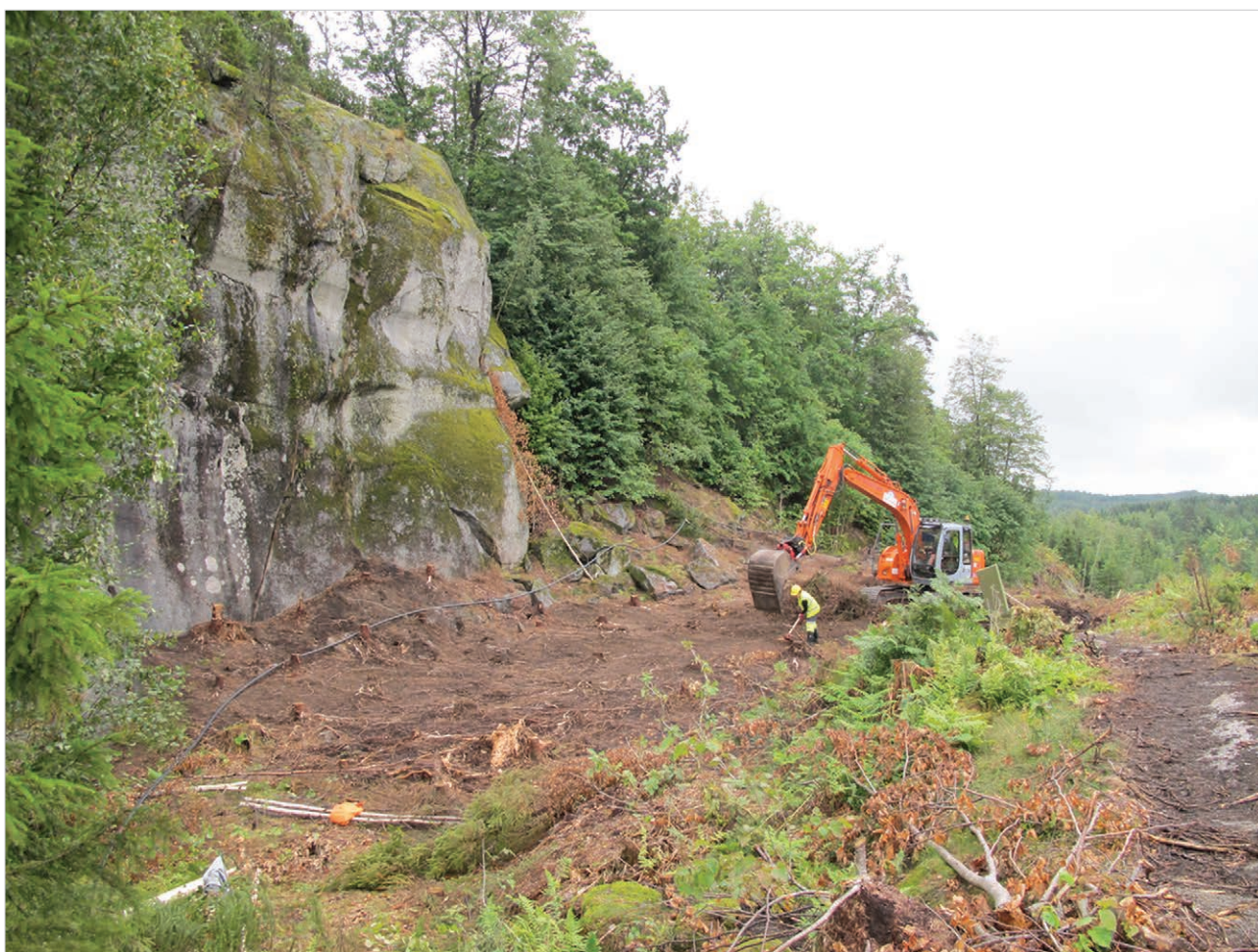
Figur 14.4.2. Avtorøying på Langangen Vestgård 4, sett mot sørsørøst.
