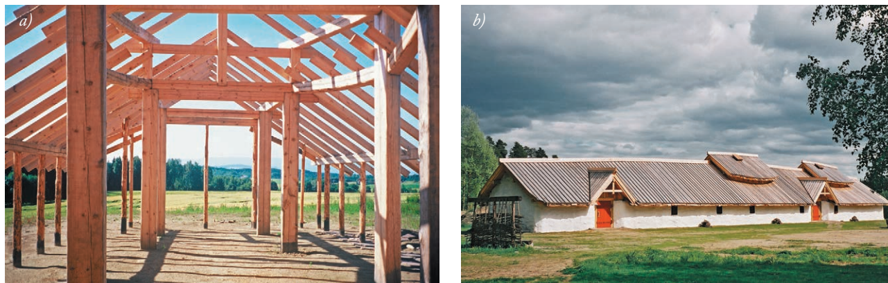
Fig. 5.13. a–b. Oppbygging av et langhus. a) Reisverket for det nye Hus I. b) Et nytt langhus, et rekonstruksjonsforslag. (Foto: KHM)
