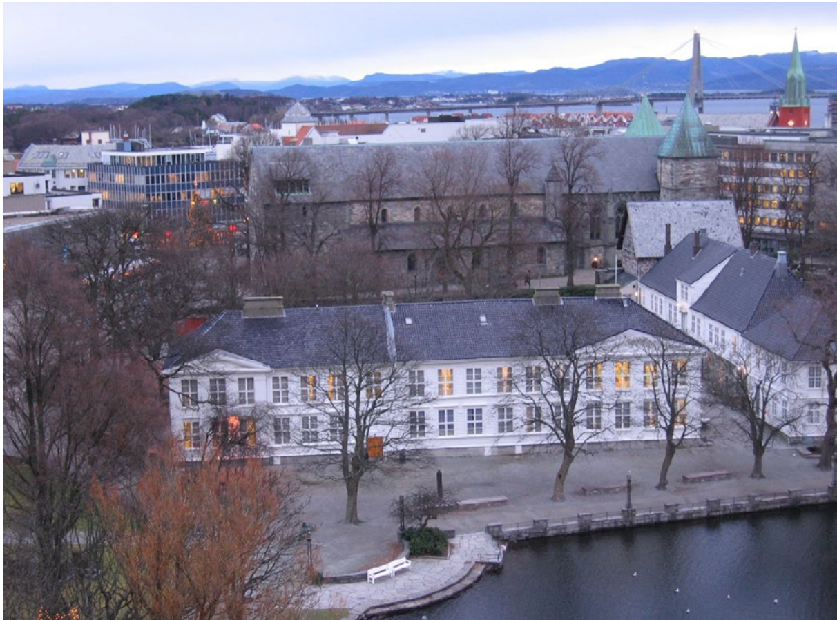
Figur 8. Stavanger domkirke med Kongsgård skole bygd på mellomalderens bispegård, alt sett frå sør. Den bevarte bispegårdsfløya i stein ligg no synleg som fyrste etasje i dagens toetasjes kvite austfløy til høgre i bildet. Fyrste etasjen er bygd saman med det toetasjes bispekapellet frå seint 1200-tal, no med eit salforma skifertak. Heile denne bispegårdsfløya har også hatt lengderetning mot koret i domkyrkja, bygd etter ein brann i 1272. Foto: Alf Tore Hommedal.
